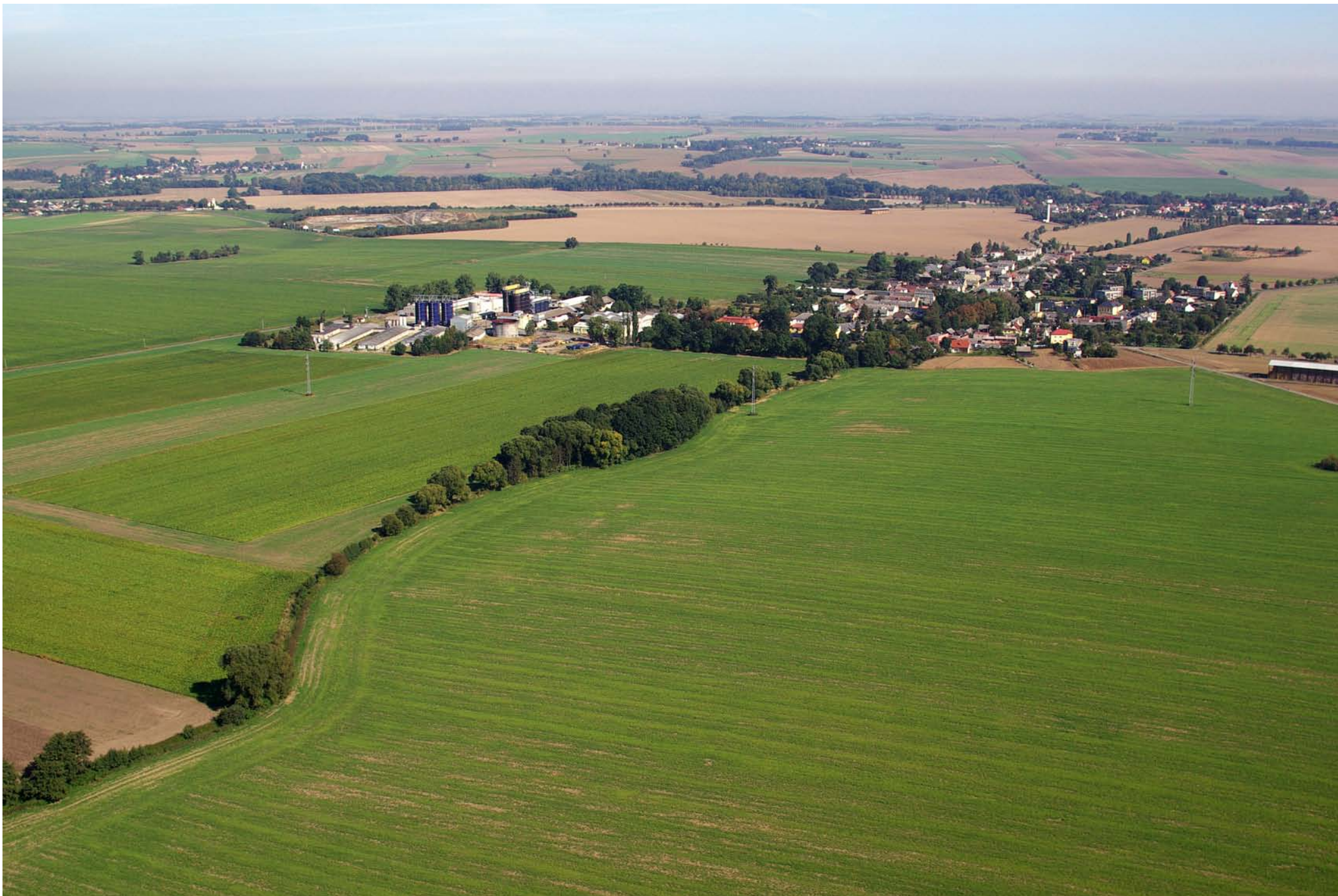
Nádrž Loděnice, celkový letecký pohled po toku - současný stav
