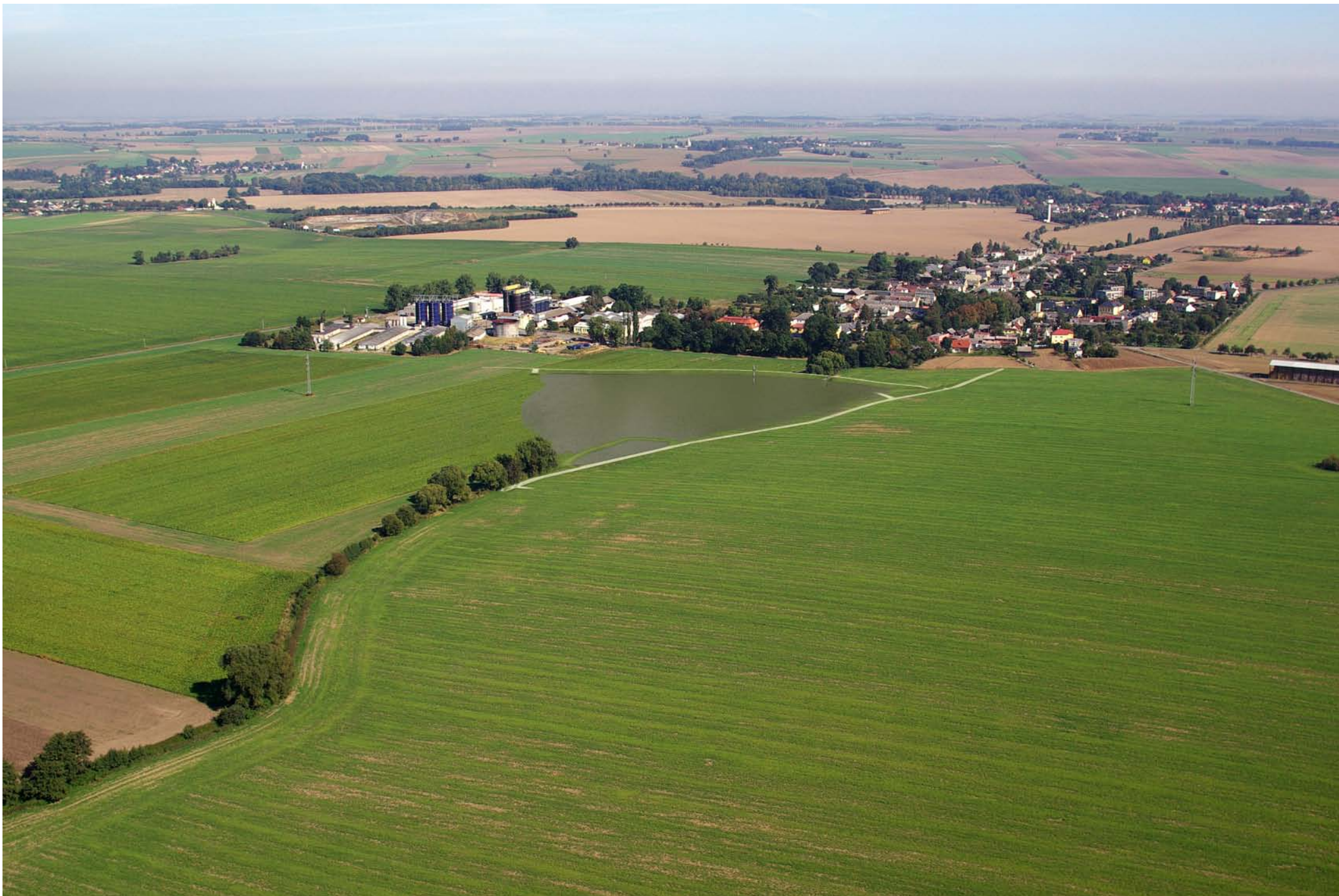
Nádrž Loděnice, celkový letecký pohled po toku - po realizaci nádrže
