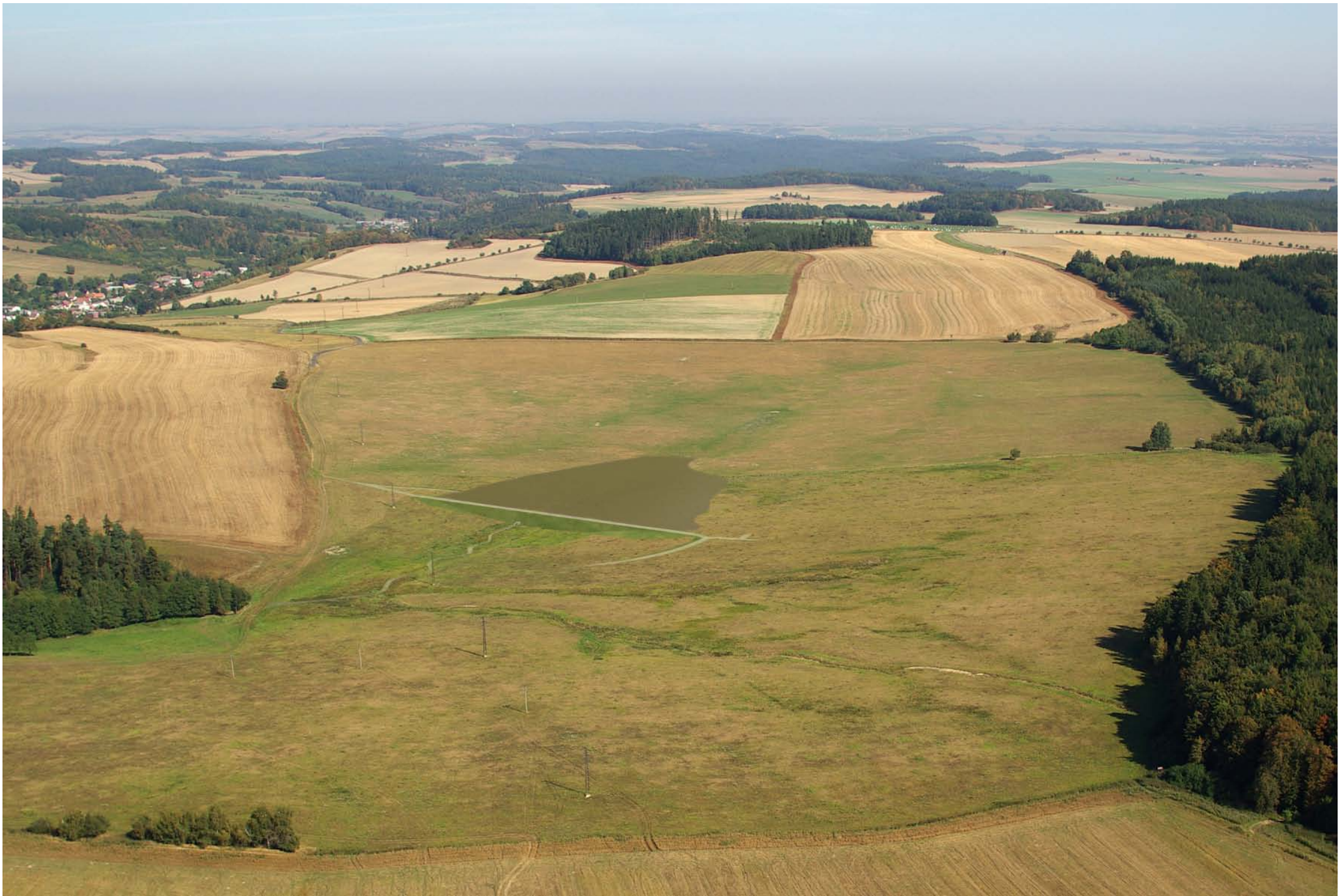
Nádrž Lichnov IV, celkový letecký pohled - po realizaci nádrže
