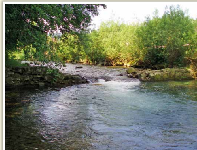
Stupeň č. 2 – původní stav
