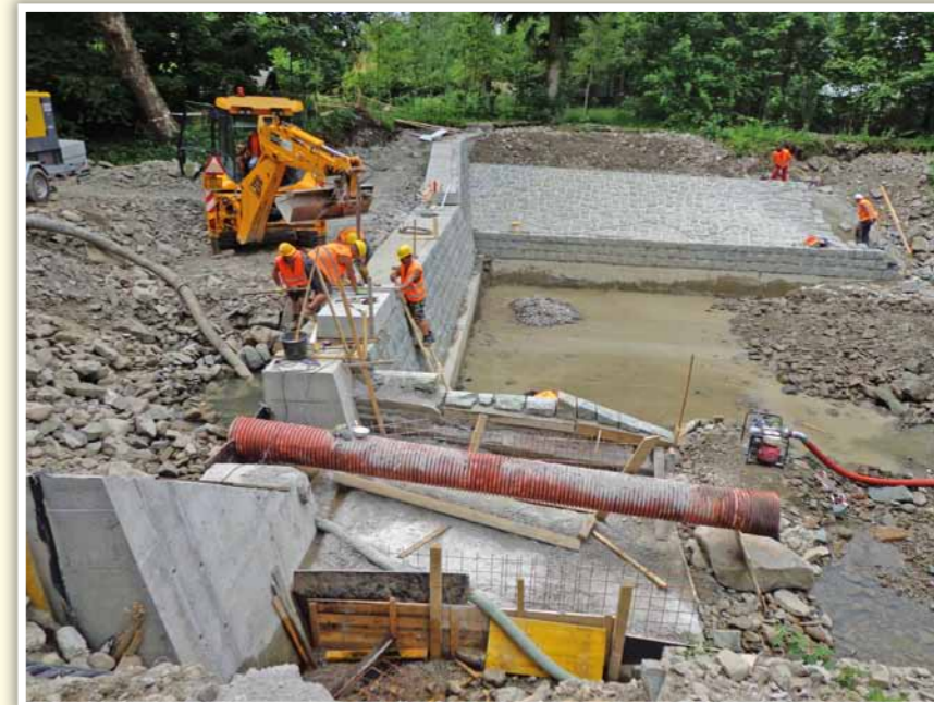
Z průběhu výstavby
