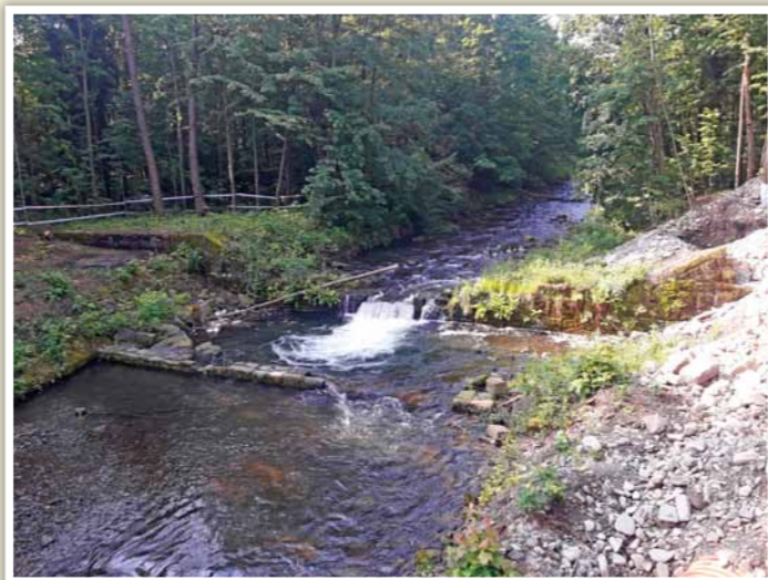
Stupeň č. 10 – původní stav
