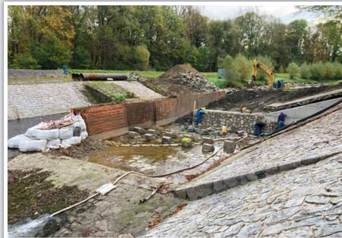
Oprava stupně na Lubině v Petřvaldě
