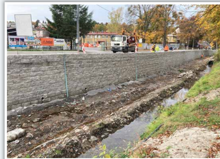
Oprava zdi na Bílovce v Bílovci
