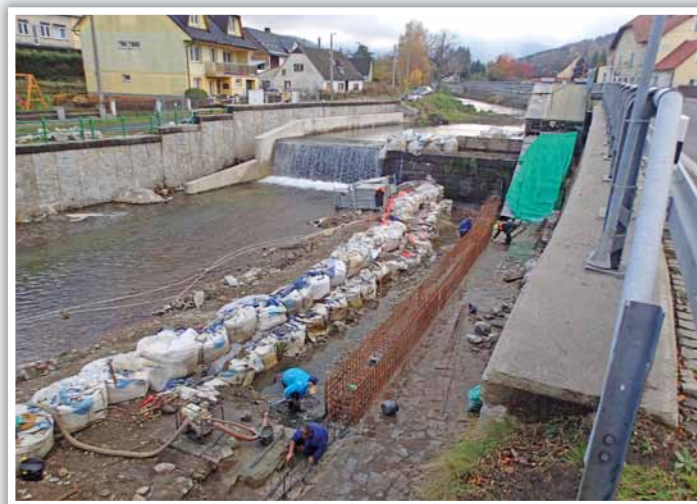
Oprava jezu Bělá – Bukovice
