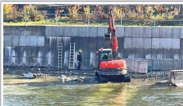
Ostravice Paskov – opěrná stěna
