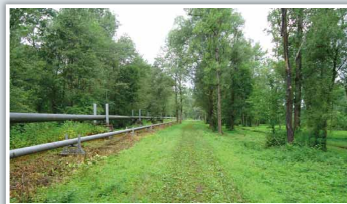
Hráz Paskov před stavbou 07-2012
