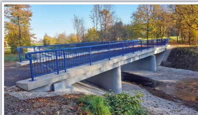
Most přes přivaděč
