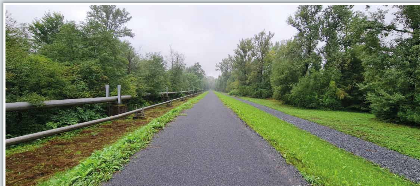
Hráz Paskov po stavbě 08-2022
