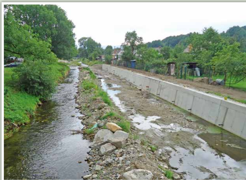
Vidnávka – rozestavěná opěrná zed' 08-2017
