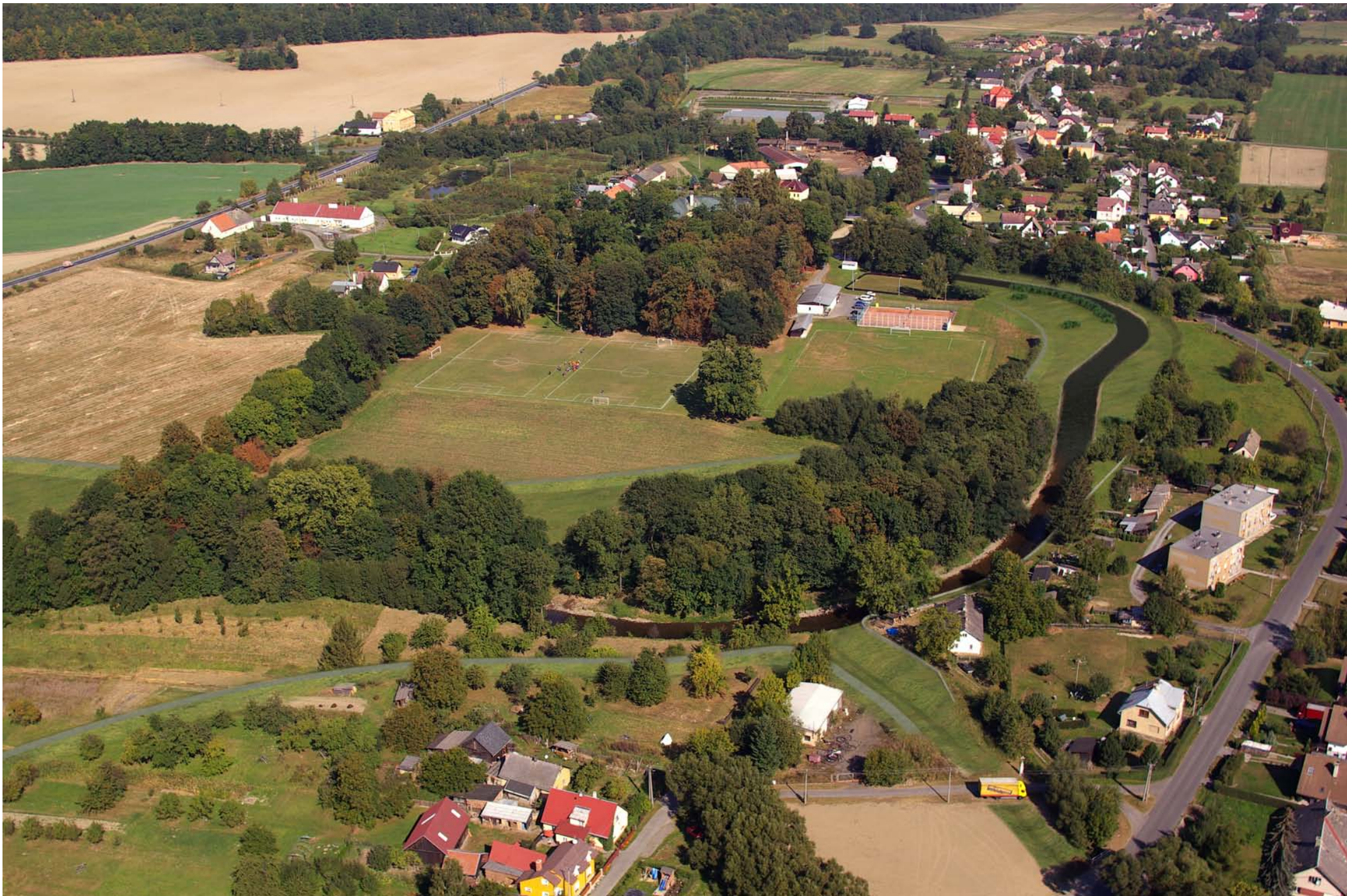
Obec Brantice, letecký pohled po vodě na úsek nad jezem v km 78,340 - po realizaci navržených opatření
