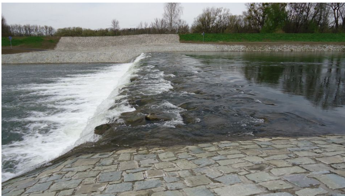
stupeň po opravě
