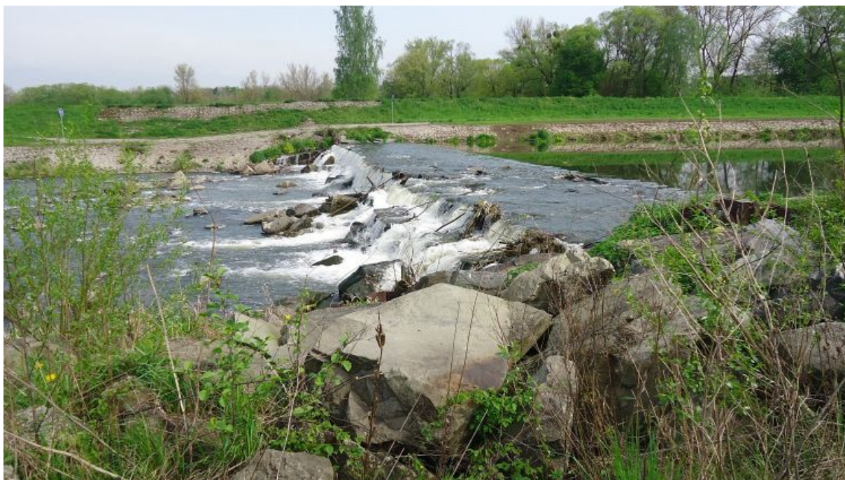
stupeň před opravou
