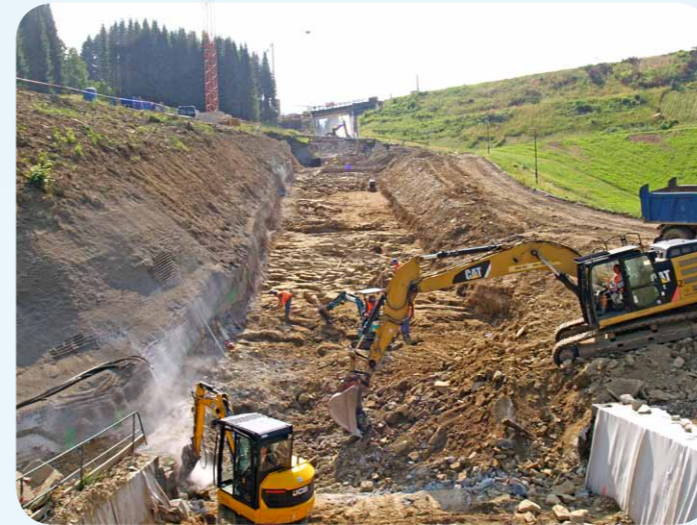
Skluz – čištění základové spáry
