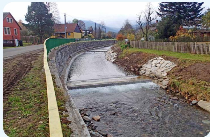
Bělá ř. km 24,150, pohled proti vodě po odstranění PŠ
