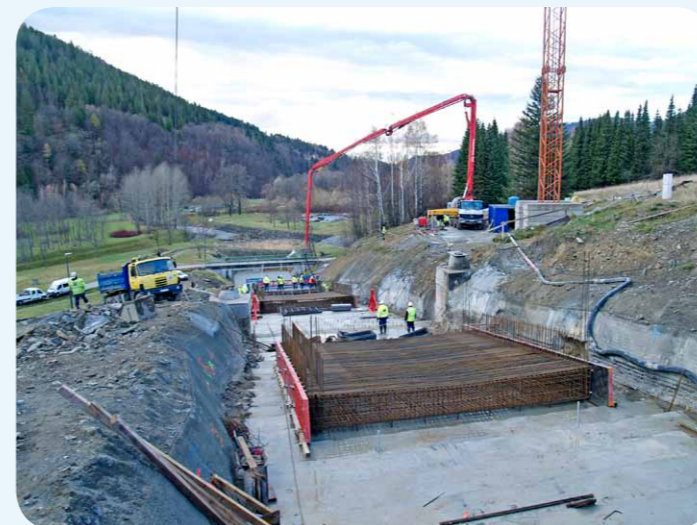
Skluz – armování a betonáž dna
