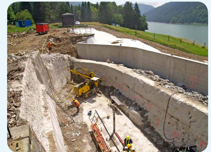
Spadiště – bourací a kotevní práce
