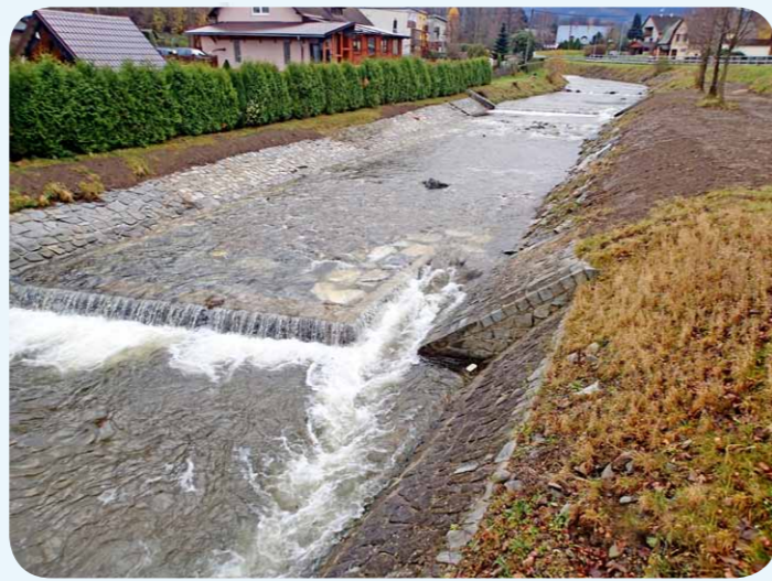
Bělá ř. km 22,600, pohled proti vodě po odstranění PŠ
