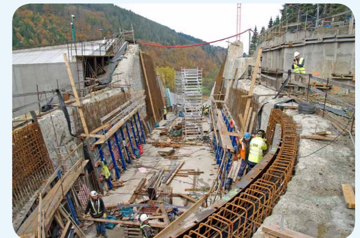
Spadiště – montáž výztuže pro přibetonávku stěn
