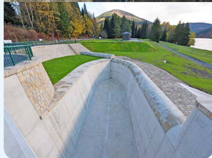
Porovnání spadiště před a po rekonstrukci
