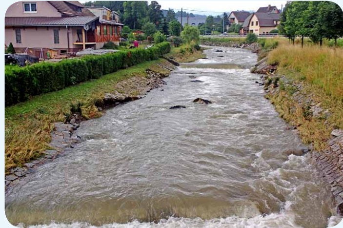
Bělá ř. km 22,600, pohled proti vodě po povodni
