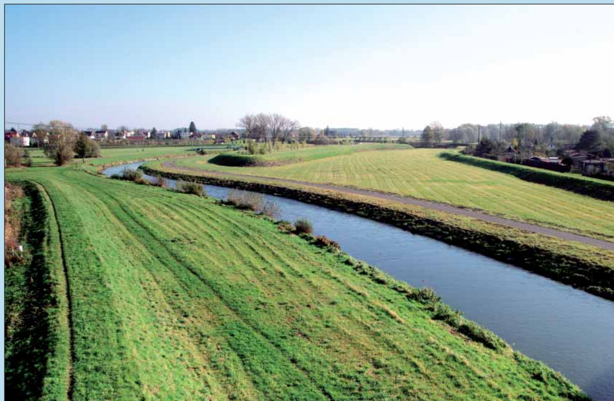
➤ Odstranění návozu z pravobřežního prostoru řeky Opavy nad trať ČD Opava - Hlučín se zvýšil stupeň ochrany před povodněmi na dolním konci městské úpravy přes Opavu.
