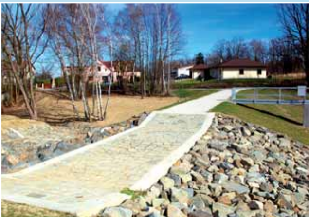
▲ Suchá nádrž Hlinský na Hlinském potoce u Místku.
