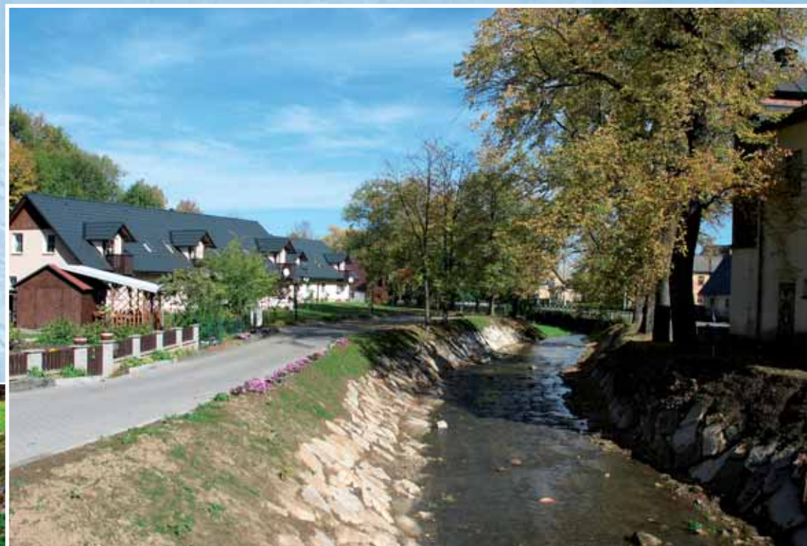
▲ Obnova úpravy koryta Vojtovického potoka po povodni r. 2009.
