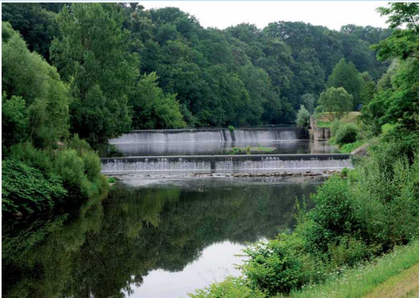
Sklonovou stabilitu hraničního úseku řeky Olše nad Českým Těšínem zajišťuje horní jez (polský) a níže ležící spádový stupeň těsně nad zaústěním toku Ropičanky.
