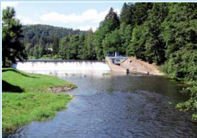
▲ Jez vyrovnávací nádrže v Podhradí.
