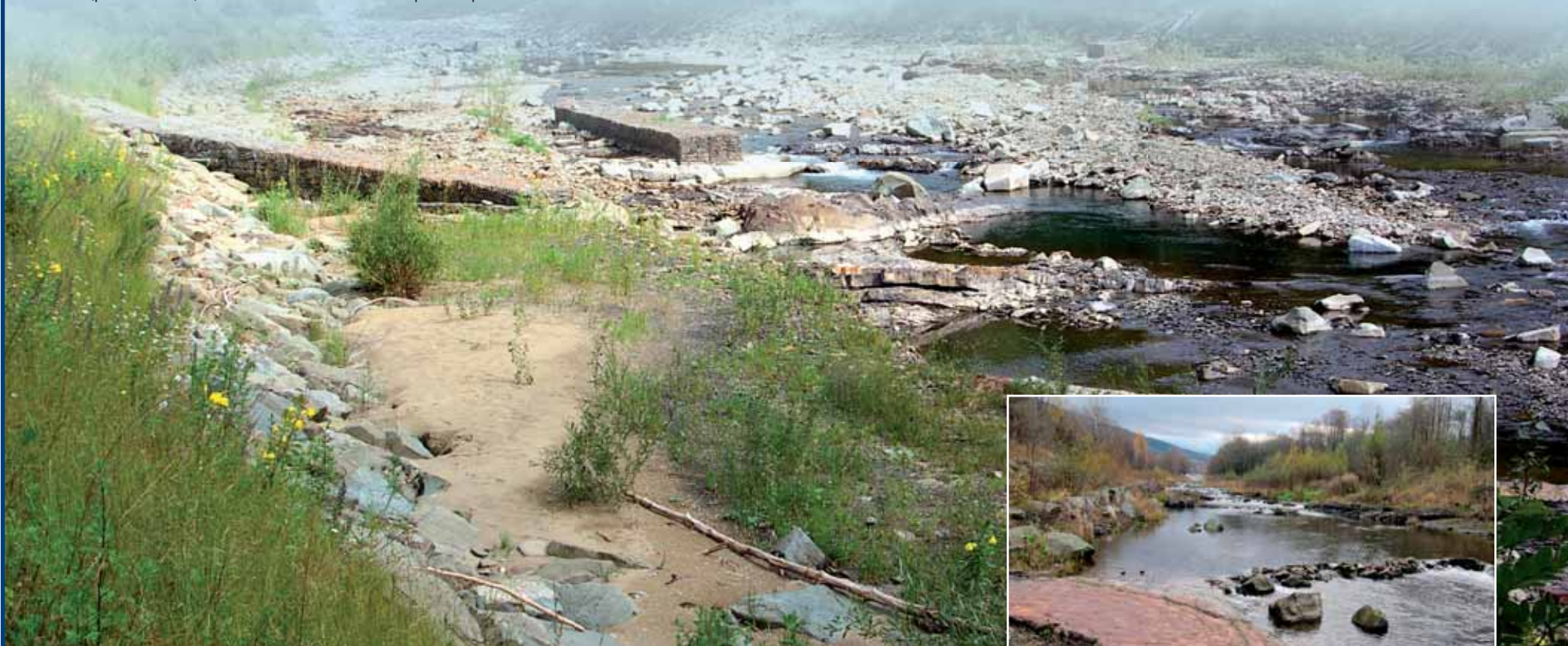
▲ ► Skalnaté zahlubující se dno řeky Morávky s umělými usměrňovacími výhony pod rozdělovacím objektem ve Vyšních Lhotách.
